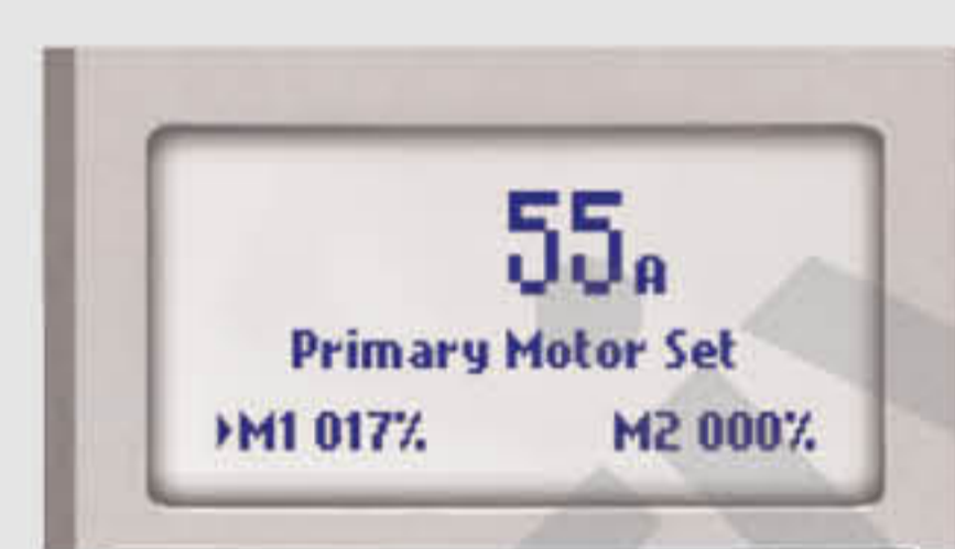
Температура двигателя, ток, мощность
